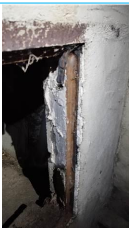
Matériaux : ZPSO-051 Prélèvement : P058 Description : Joint trappe Localisation : Sous-Sol - cave 1 Résultat : Absence d'amiante
