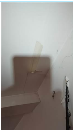
Matériaux : ZPSO-018 Prélèvement : P024 Description : Bandes calicot Localisation : 2ème étage - pièce 6 Résultat : Absence d'amiante
