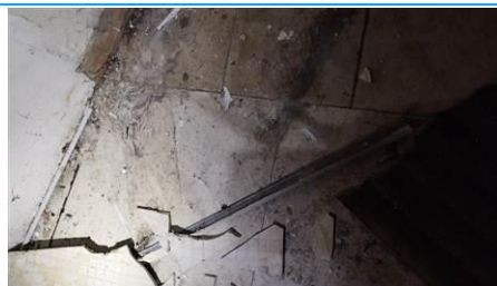
Matériaux : ZPSO-043 Prélèvement : P049 Description : Colle de plinthe Localisation : Rez de chaussée - réserve Résultat : Absence d'amiante
