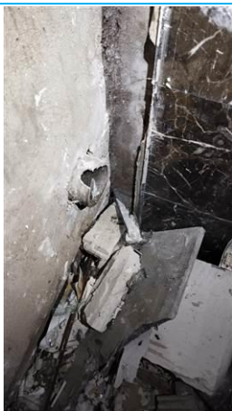
Matériaux : ZPSO-044 Prélèvement : P050 Description : Conduit en fibres-ciment Localisation : Rez de chaussée - salle de restaurant 1 Résultat : Présence d'amiante
