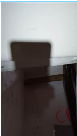
Matériaux : ZPSO-024 Prélèvement : P030 Description : Enduit à base de plâtre projeté Localisation : Rez de chaussée - salle restaurant 2 Résultat : Absence d'amiante
