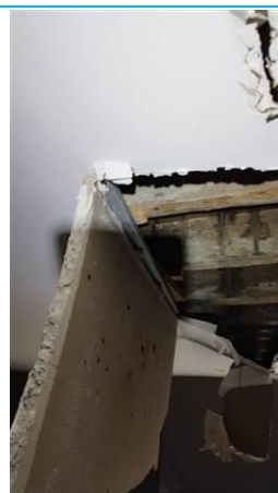
Matériaux : ZPSO-023 Prélèvement : P029 Description : Bandes calicot Localisation : Rez de chaussée - salle restaurant 2 Résultat : Absence d'amiante
