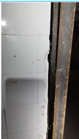
Matériaux : ZPSO-048 Prélèvement : P054 Description : Colle de faïence Localisation : Sous-Sol - cave 1 Résultat : Absence d'amiante
