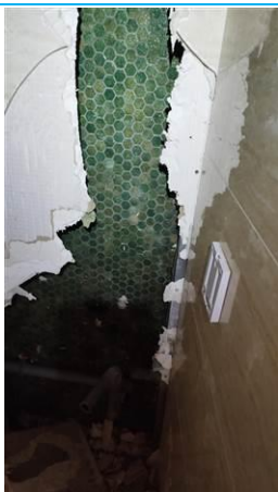
Matériaux : ZPSO-030 Prélèvement : P036 Description : Colle de faïence verte Localisation : Rez de chaussée - sanitaires Résultat : Absence d'amiante
