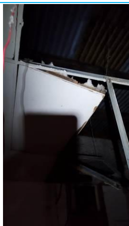
Matériaux : ZPSO-038 Prélèvement : P044 Description : Panneaux et plaques Localisation : Rez de chaussée - cuisine Résultat : Absence d'amiante
