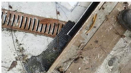
Matériaux : ZPSO-003 Prélèvement : P006 Description : Colle de carrelage Localisation : Rez de chaussée - terrasse arrière Résultat : Absence d'amiante
