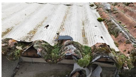
Matériaux : ZPSO-005 Prélèvement : P010 Description : Plaques en fibres-ciment (y compris plaques « sous tuiles ») Localisation : toiture dessus salle restaurant 1 Résultat : Présence d'amiante
