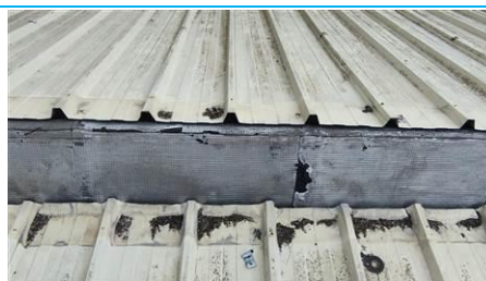
Matériaux : ZPSO-002 Prélèvement : P003 Description : Jonction bitumineuse Localisation : toiture dessus salle restaurant 1 Résultat : Absence d'amiante
