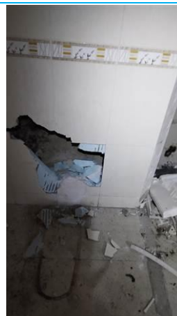
Matériaux : ZPSO-045 Prélèvement : P051 Description : Colle de faïence Localisation : Rez de chaussée - sanitaire Résultat : Absence d'amiante
