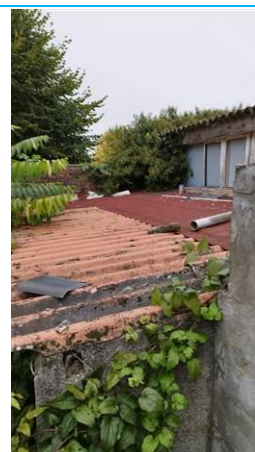
Matériaux : ZPSO-005 Prélèvement : P011 Description : Plaques en fibres-ciment (y compris plaques « sous tuiles ») Localisation : toiture dessus salle restaurant 1 Résultat : Présence d'amiante
