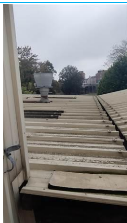
Matériaux : ZPSO-002 Prélèvement : P004 Description : solin bitumineu cheminée Localisation : toiture dessus salle restaurant 1 Résultat : Absence d'amiante
