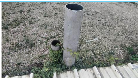
Matériaux : ZPSO-001 Prélèvement : P001 Description : Conduit en fibres-ciment Localisation : Rez de chaussée - pignon droit Résultat : Présence d'amiante
