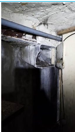
Matériaux : ZPSO-049 Prélèvement : P056 Description : Conduit en fibres-ciment Localisation : Sous-Sol - cave 1 Résultat : Présence d'amiante
