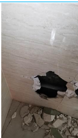
Matériaux : ZPSO-028 Prélèvement : P034 Description : Colle de faïence Localisation : Rez de chaussée - sanitaires Résultat : Absence d'amiante
