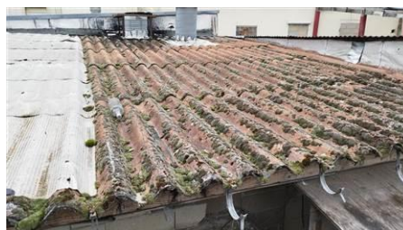
Matériaux : ZPSO-002 Prélèvement : P005 Description : bitumineuse Localisation : toiture dessus salle restaurant 1 Résultat : Absence d'amiante
