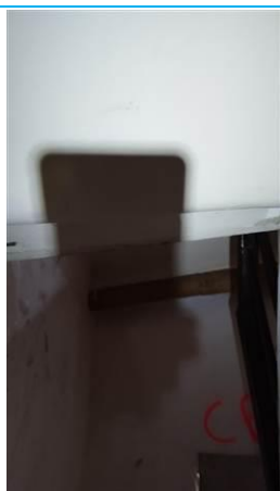
Matériaux : ZPSO-010 Prélèvement : P016 Description : Enduit à base de plâtre projeté Localisation : 1er étage - palier 1 Résultat : Présence d'amiante
