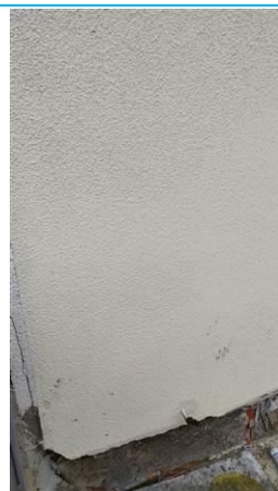
Matériaux : ZPSO-021 Prélèvement : P027 Description : Enduit extérieur (projeté, lissé ou taloché) Localisation : Rez de chaussée - façade arrière Résultat : Absence d'amiante
