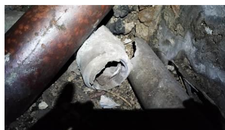
Matériaux : ZPSO-052 Prélèvement : P059 Description : Conduit en fibres-ciment Localisation : Sous-Sol - cave 1 Résultat : Présence d'amiante
