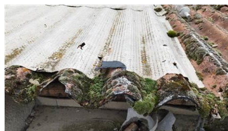
Matériaux : ZPSO-002 Prélèvement : P009 Description : bitumineuse Localisation : toiture dessus salle restaurant 1 Résultat : Absence d'amiante
