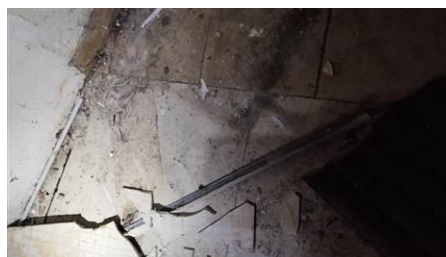
Matériaux : ZPSO-041 Prélèvement : P047 Description : Panneaux et plaques Localisation : Rez de chaussée - réserve Résultat : Absence d'amiante
