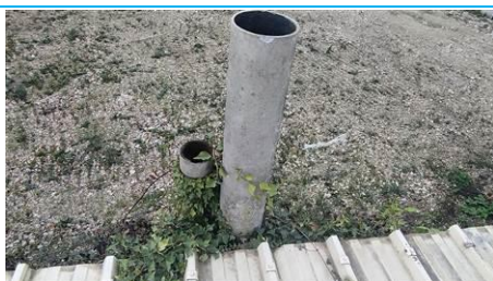
Matériaux : ZPSO-001 Prélèvement : P002 Description : Conduit en fibres-ciment Localisation : Rez de chaussée - pignon droit Résultat : Présence d'amiante
