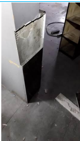
Matériaux : ZPSO-032 Prélèvement : P038 Description : Colle de faïence Localisation : Rez de chaussée - entrée Résultat : Absence d'amiante
