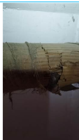
Matériaux : ZPSO-011 Prélèvement : P017 Description : Calorifuge (tresses, coquilles, matelas...) Localisation : 1er étage - palier 1 Résultat : Absence d'amiante
